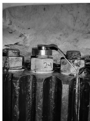
图8 云南省某风场叶根螺栓监测
